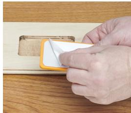
**4)** Entfernen Sie das Schutzpapier von der Butyldichtung auf dem Floor Sentry und bringen Sie das Gerät so an, dass die Butyldichtung mit dem Holz im Hohlraum verbunden ist. Fahren Sie anschließend wie geplant mit der Verlegung des Fußbodens fort.
