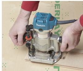
**3)** Verwenden Sie eine Oberfräse oder ein ähnliches Gerät, um einen Hohlraum für das Floor-Sentry-Gerät in der Unterseite der Holzdiele zu schaffen.
